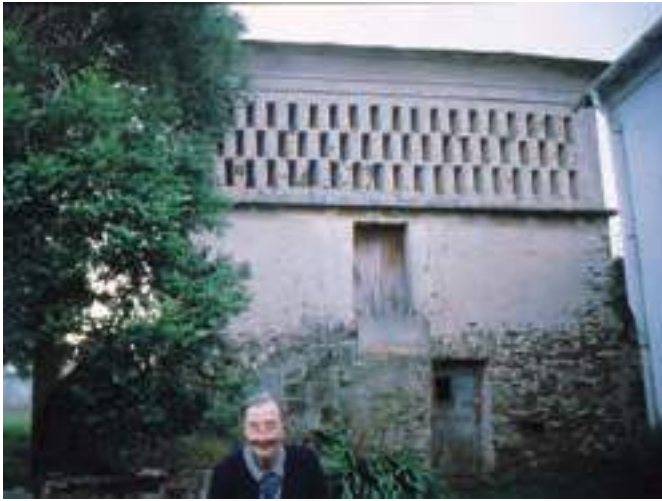
Villadún (Barres, Castropol) es una de las pocas localidades donde todos los graneros son de piedra, algunos de gran antigüedad. Cabazo de tres pisos en Casa del Mono.
