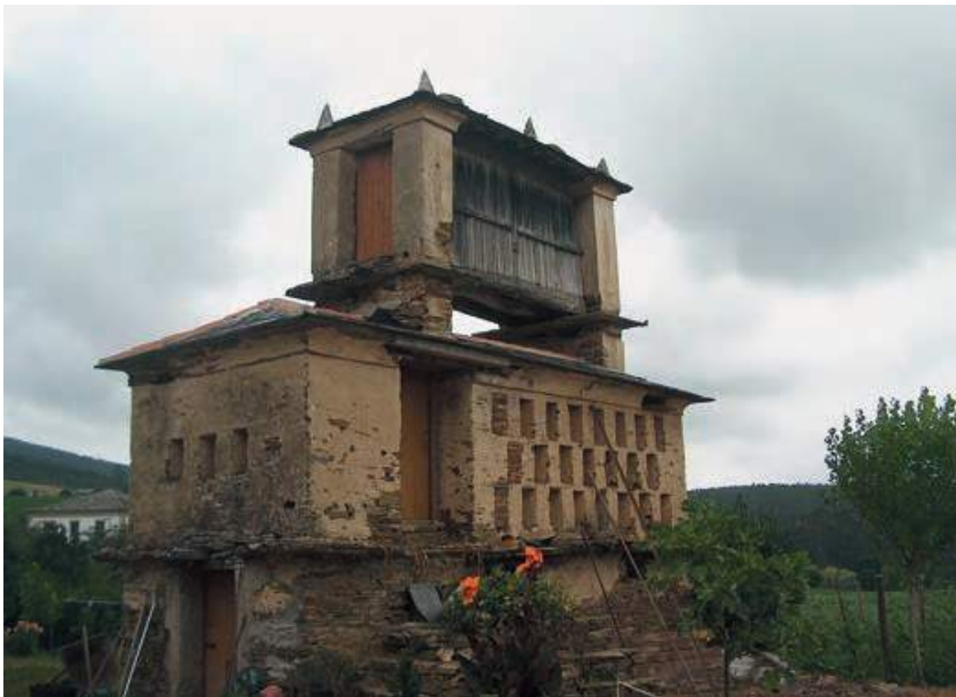
Granero con dos cámaras independientes y sobrepuestas. Casa Caseiro (Salcedo, Ribadeo).
