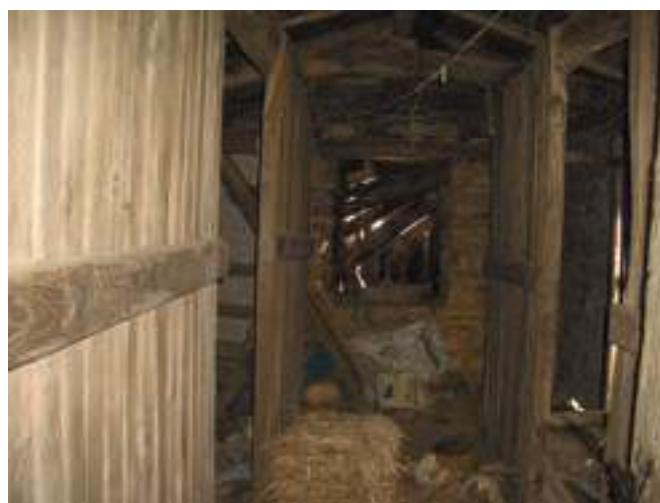
Cámara con pasillo central y accesos a las zonas de secado lateral. Casa Lanas (Leiras, Taramundi).
