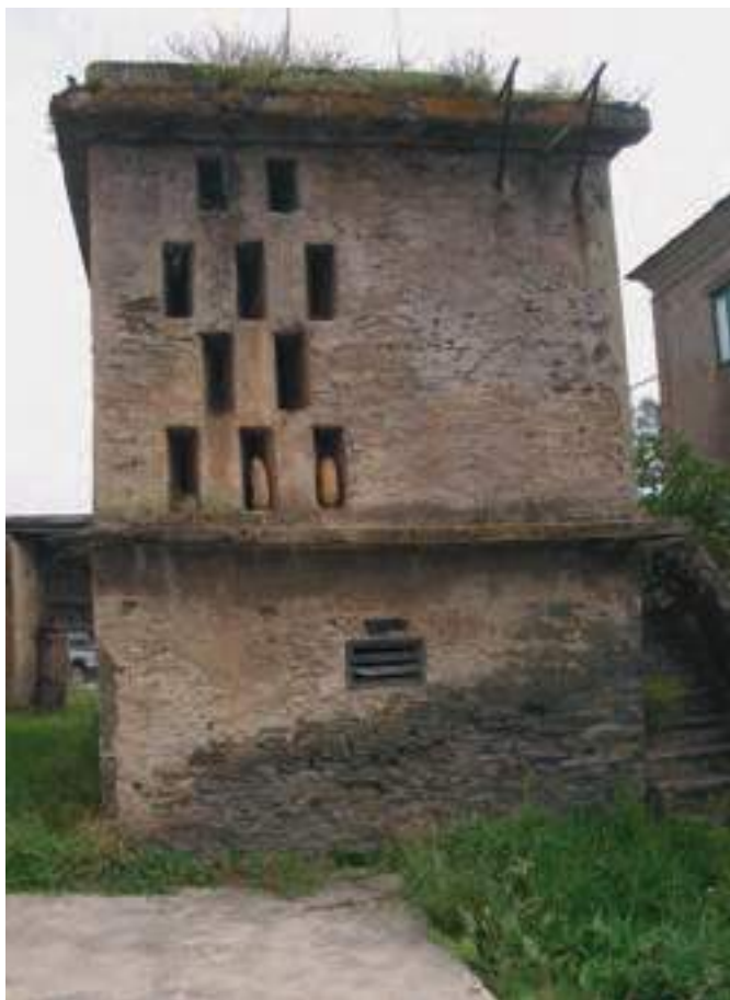
Troneras en una granera que le dan el aspecto de un cabazo de piedra tipo Ribadeo. Casa Solares (Armental, Navia).
