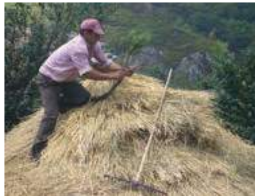
El cosido de la cubierta se inicia en la parte superior insertando la primera uz .
