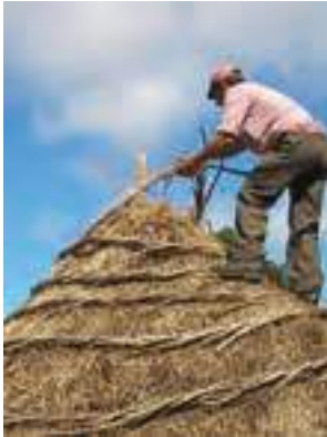
Desmontando el remate del techo.
