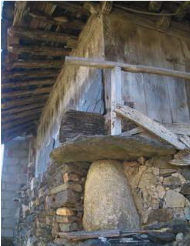
Pie de granito redondeado en un hórreo. Casa del Cuarto (Roza-das, Boal).
