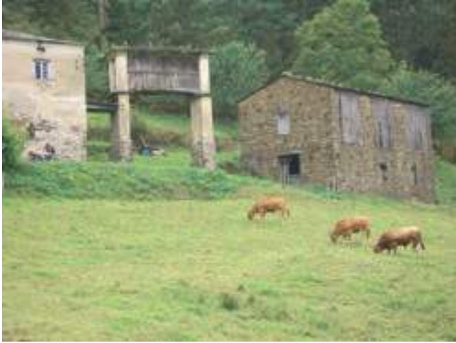
Cabazo elevado para evitar las limitaciones del terreno y adaptarse al nivel de la vivienda. Casa Señorín (Ferreirameón, Vegadeo).
