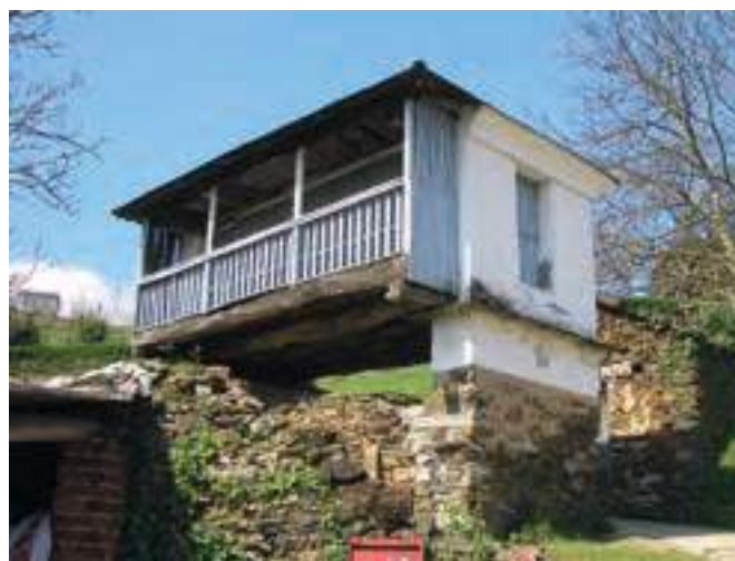
Cabazo con corredor exterior orientado al valle, en el que toda la estructura vuela fuera de las cepas. Casa Concha (La Escrita, Boal).
