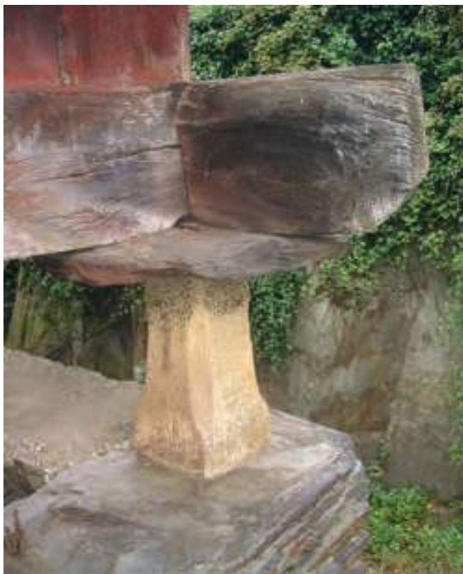
Pie de sillería de granito en una panera. Casa del Mazo (Armental, Navia).
