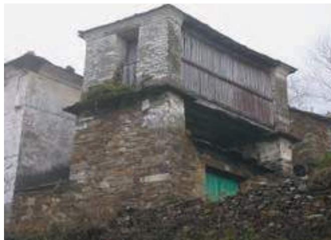
Los graneros con cepas desescuadradas para adaptarse al entorno inmediato y aprovechar el espacio son más abundantes en los de tipo mixto y en zonas de Montaña. Casa Ferreiro (Sarzol, Illano).
