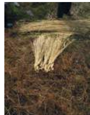
El remate de los haces superiores se hace mediante la colocación de diversas trenzas de paja ( garañolas ) que conforman una estructura elástica que mantiene prensada ( huevo ).
