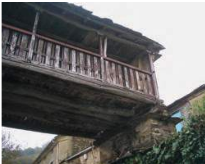
Cabazo con corredores en ambos costales que vuelan por fuera de las cepas. En este caso, los pontones, en número de cinco, no se insertan directamente en la cepa sino que se apoyan en una viga transversal. Obsérvese también la distribución de los pontones en función de las cámaras superiores. Casa de Veiga (Nío de Abajo, Taramundi).
