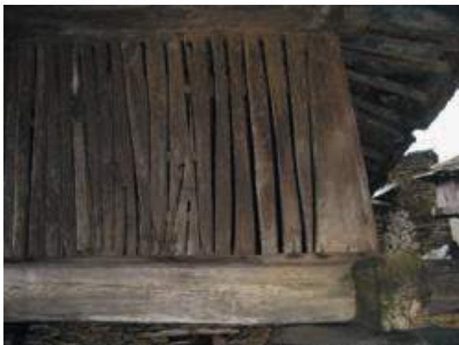
Colondras ranuradas para ventilación de la cámara en un hórreo antiguo. Casa Morán (San Esteban, Illano).
