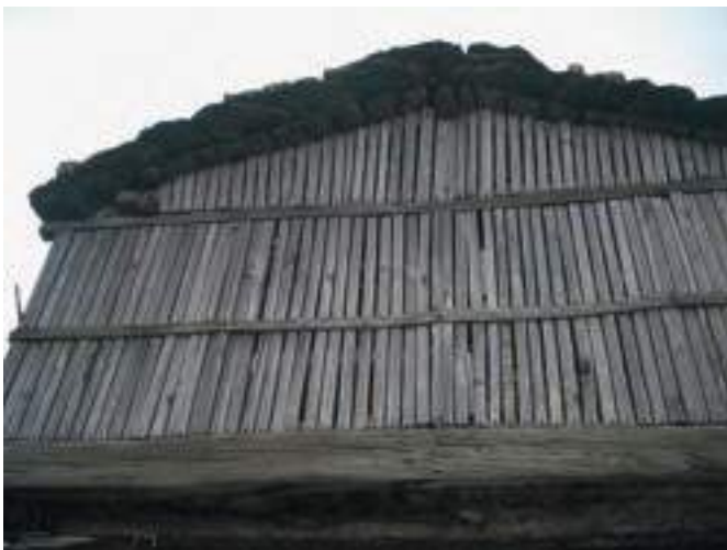
Granero especial con zonas de almacenaje y secado, como este penal cerrado enteramente con duela. Cubierta a tres aguas y pies de mampostería. Casa Quintana (Piñeiro de Arriba, Taramundi).
