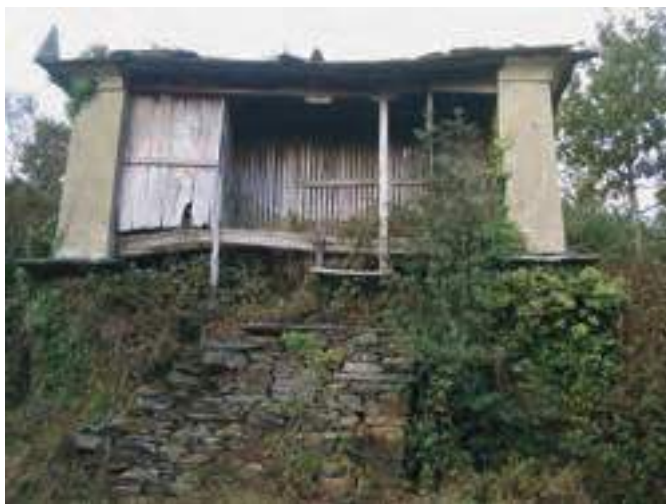
Costal de un granero de uso mixto que muestra, de izquierda a derecha: zona de almacenaje cerrada, corredor y zona de almacenaje para la matanza. Casa El Batinote (El Batinote, A Pontenova).
