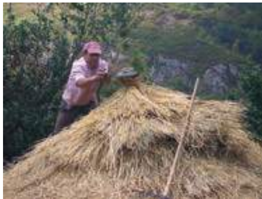
El cosido de la cubierta se inicia en la parte superior insertando la primera uz .
