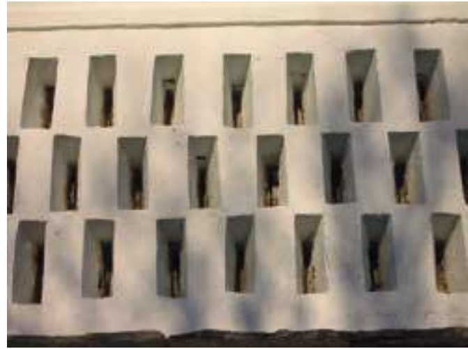
Tronerías de tamaño normal y espaciado regular. Casa Peleyón (Figueras, Castropol).
