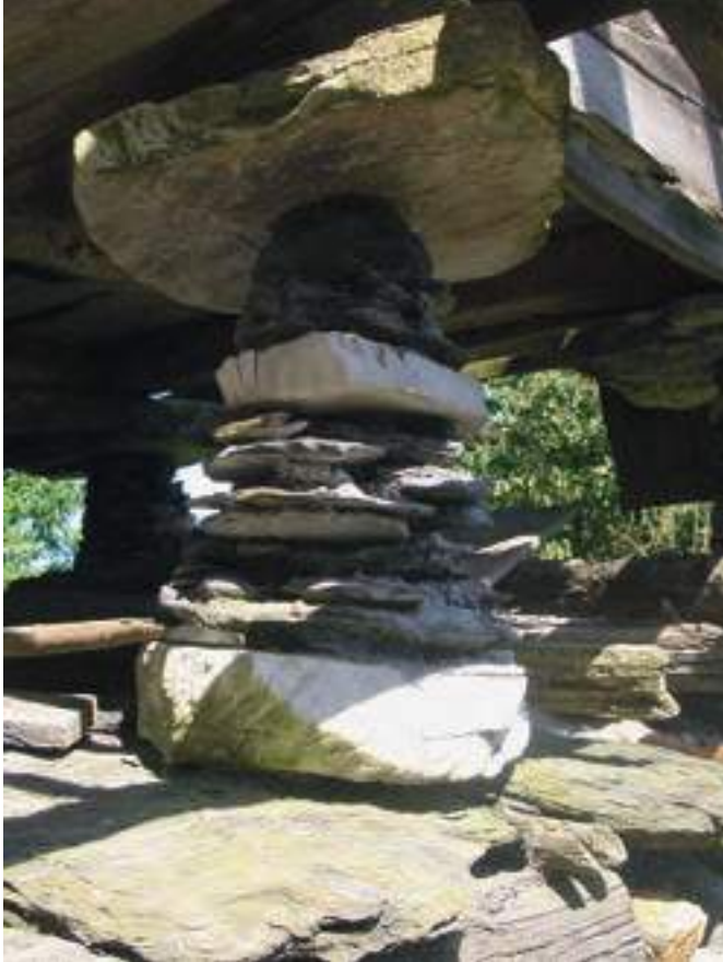
Pie de mampostería gruesa combinando pizarra y cuarcita. Casa Chope (Caborno, Valdés).
