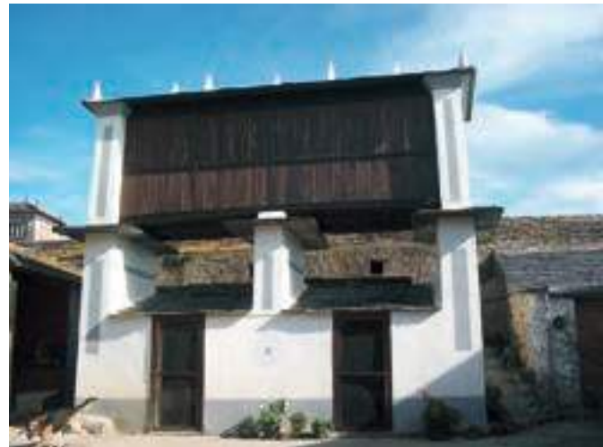
Cabazo con tres cepas y celeiros inferiores. La cepa central sólo actúa como apoyo de las vigas. Casa Xan da Pena (Río, Ribadeo).
