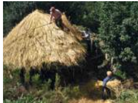
Colocando y distribuyendo correctamente la paja.
