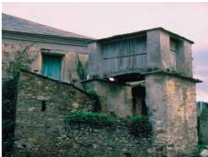
Excelente ejemplo de cabazo desaparecido en posición congruente en la que se ha sacrificado la accesibilidad a la vivienda. Casa Francisco (Valín, Castropol).
