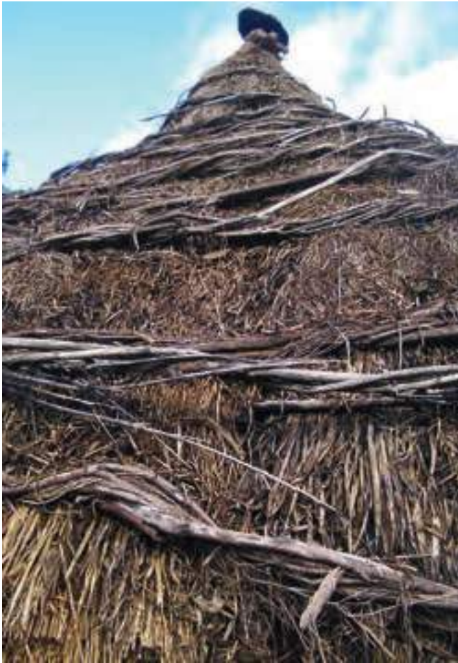
Las cubiertas de paja techadas a beo eran muy frecuentes en lo hórreos del occidente asturiano y concejos gallegos limítrofes. Casa Muíña (Xestoso, Grandas).
