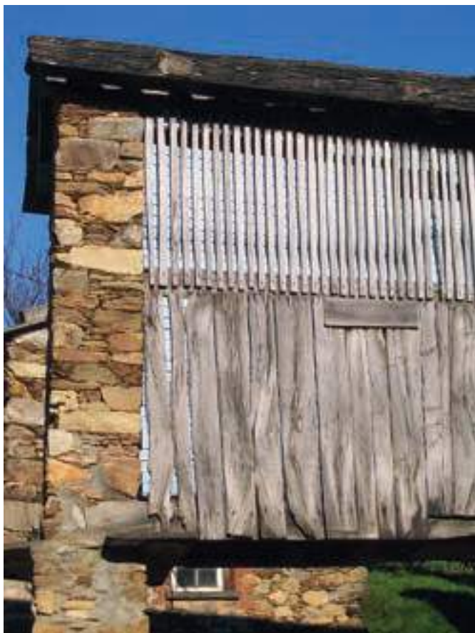
Cierre de duelas y tablones en transición vertical característico de algunas zonas altas del concejo de Valdés y sectores limítrofes. Casa del Rey (Villartorey, Villayón).
