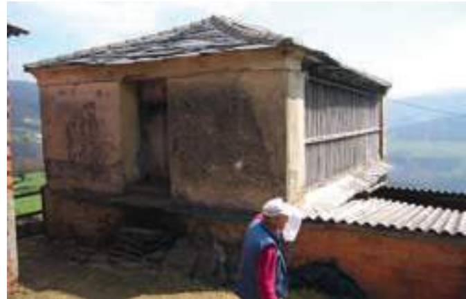
Cabazo muy ancho y de poca altura, que permite un acceso casi directo a la cámara desde el suelo. Casa del Xordo (Muñón, Boal).
