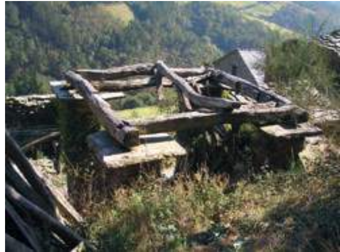
Estructura con encajes y traveses dobles de un hórreo especial de la zona suroccidental. Casa Meirín (Cancelos de Abaixo, Taramundi).
