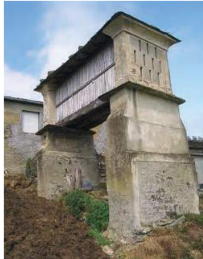
Cepas de sección decreciente, aleros amplios y cubiertas laxas o de bajo ángulo son algunas de las características de los cabazos antiguos que les confieren sin duda un gran porte y belleza. Casa A Pruida (Almedía, Vegadeo).
