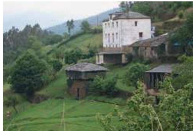
En amplias zonas del occidente asturiano y oriente de Lugo coexisten graneros de secado y de almacenaje, mostrando diversas relaciones entre ellos. Cabazo y panera en Casa Río de Veiga (Miñagón-Pendia, Boal).
