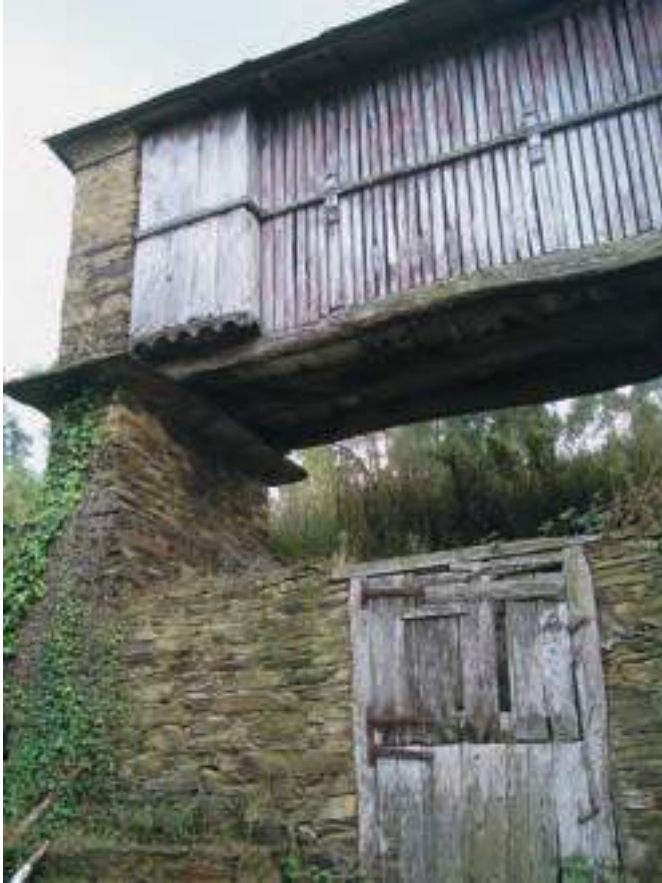
Zona de almacenamiento recrecida en los costales de un cabazo mixto. Casa Violo (El Cobre, Vegadeo).
