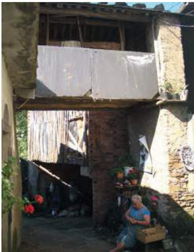
Corredor construido con lajas de pizarra. Casa Peralonso (Miñagón, Boal).
