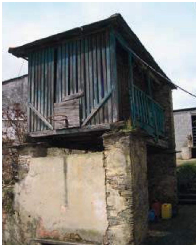
Granero de uso mixto con corredor construido en madera. Casa Baragaña (Villapedre, Navia).
