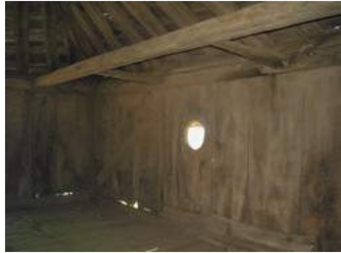
Viguetas paralelas en un hórreo. Casa Pericón (Barbeitín, Navia).
