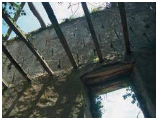
Interior de un granero de piedra que muestra su estructura. Casa Trina (La Muria, Castropol).
