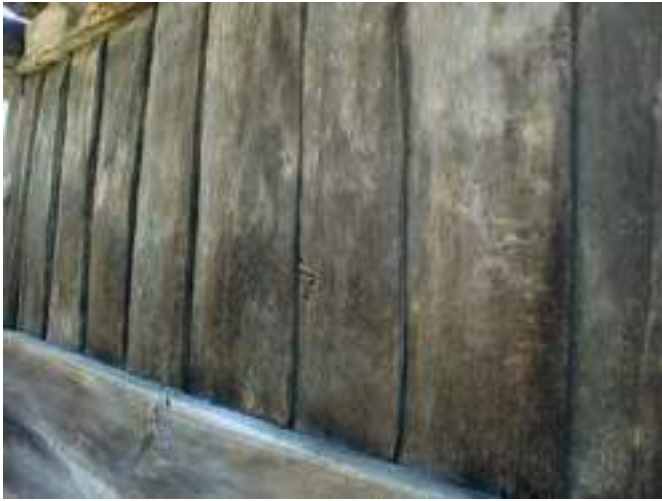
Colondras antiguas talladas a azuela y con machihembrado simple. Hórreo Casa Zapatón (Fornaza, A Fonsagrada).
