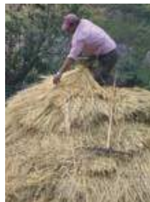
El remate de los haces superiores se hace mediante la colocación de diversas trenzas de paja ( garañolas ) que conforman una estructura elástica que mantiene prensada ( huevo ).
