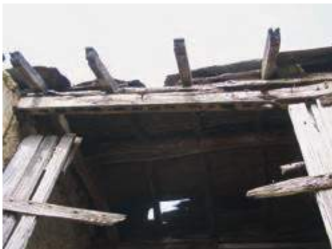
Pequeño cabazo modelo antiguo a tres aguas y detalle del encaje de las duelas anchas sobre los liños, técnica ésta muy poco común. Casa Pedrón (Granda, Castropol).
