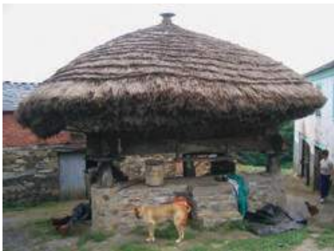
El concejo de Grandas es uno de los más ricos en cubiertas de paja. Hórreo de teito con aleros de brezo y varias capas de paja bien conservado en Casa A Lieira (A Lieira, Grandas).
