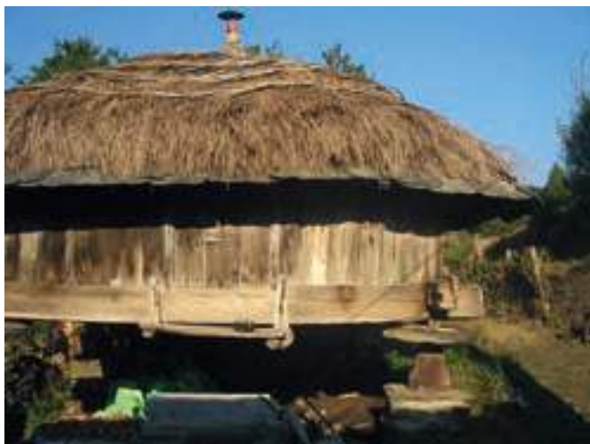
Granero de almacenamiento con cubierta vegetal y alero de pizarra. Los hórreos de esta zona, en su mayoría de tipo asturiano, estaban cubiertos con paja de centeno. Casa de Baxo (Pasarón, Villanueva de Oscos).
