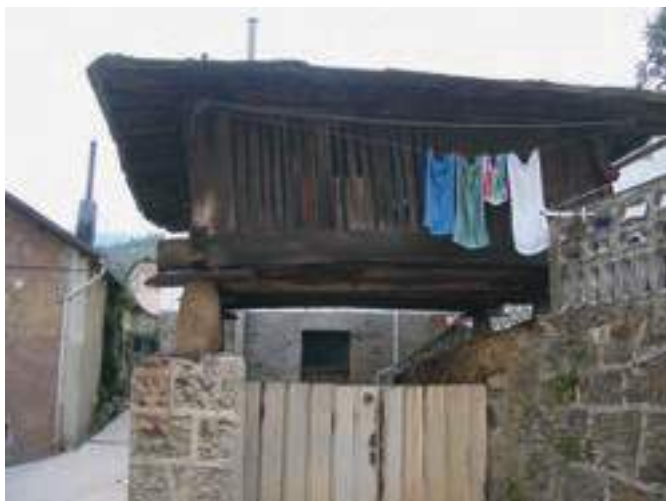
Hórreo con cabazo para secado integrado en la cámara y orientado al sur. Casa Xiquín (Doiras, Boal).
