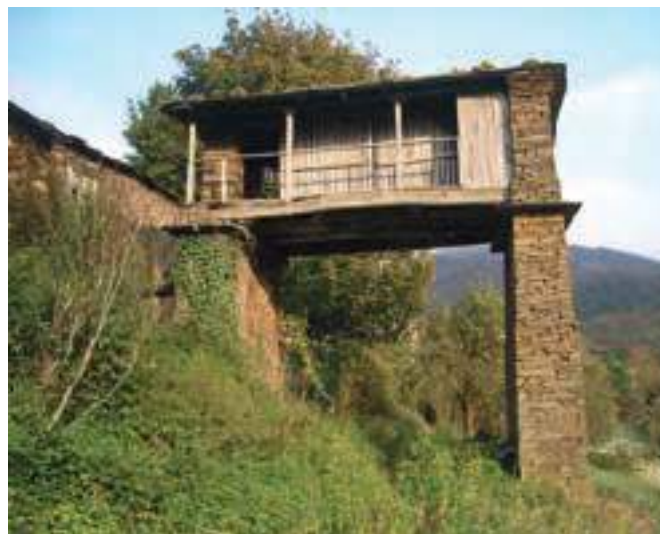
Granero de uso mixto con doble corredor. Puede observarse como las cepas son diferentes a nivel de la cámara. En este caso, el acceso a la cámara se realiza mediante una puerta central. Al fondo del costal se aprecia un pequeño compartimento de almacenamiento. Casa do Juez (Taramundi).
