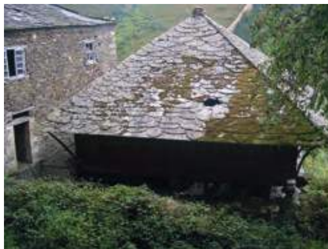
El hórreo de la Casa Vella de Vilarello (Allonca, A Fonsagrada) es el más grande en la zona de estudio. Alcanza los 10 metros de longitud entre aleros y es muy rico en estructuras internas.
