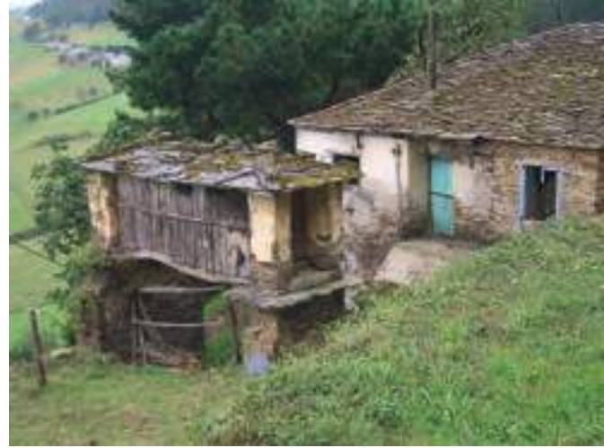
Cabazo a la puerta de la casa y adaptándose a la morfología del terreno. Casa Gayol (Cereixido, Vegadeo).
