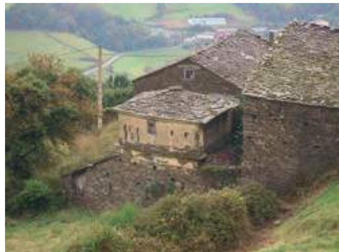
Granero especial de planta poligonal y uso mixto, con estructuras de secado en ambos costales. Casa Tía Rosa (Lourido, Taramundi).
