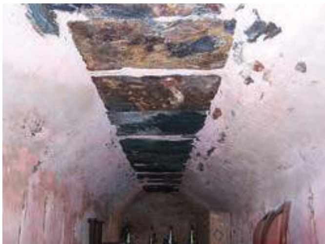
Bóveda de losas en la cámara de un granero de piedra. Casa Bruno (Mernes, El Franco).
