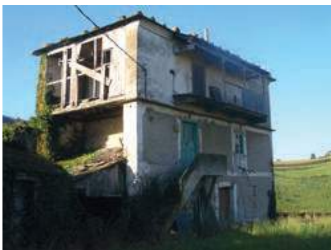
Granera de grandes dimensiones, inspirada en un cabazo de piedra, con dos balconadas (costal y penal) y cámara superior ventilada. Casa del Estudiante (Villabona, Navia).
