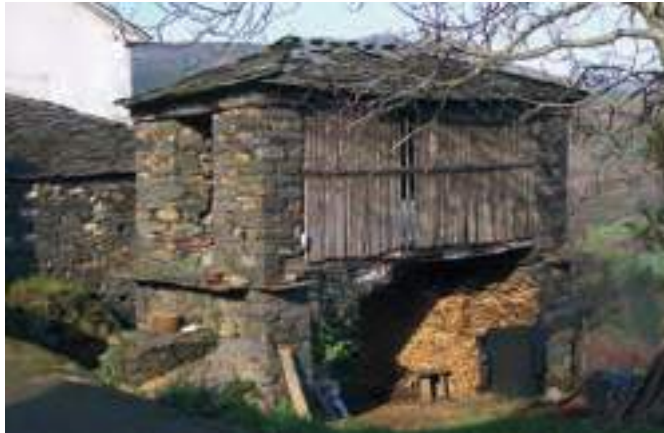
Cabazo de uso mixto con remate de la cubierta mediante pizarras trabadas. Casa da Cruz (Silvón, Boal).
