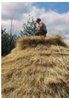
En la zona apical es necesario colocar un espesor superior de paja, y es la única parte del hórreo en la que los haces se doblan, para asegurar la estanqueidad de la cubierta.
