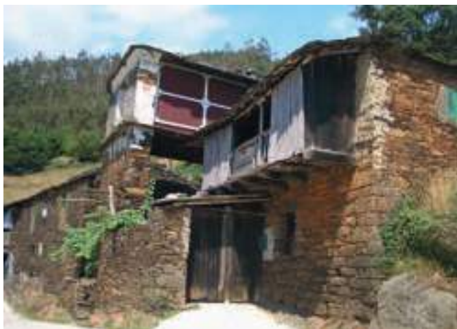
Granero de uso mixto ubicado muy próximo a la vivienda. Casa Arroyo (Zedemonio, Illano).
