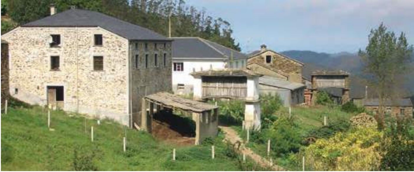
Cabazos perpendiculares a la ladera y ubicados en la parte inferior de las viviendas, libres de interferencias de otras construcciones. Fabal, Taramundi.
