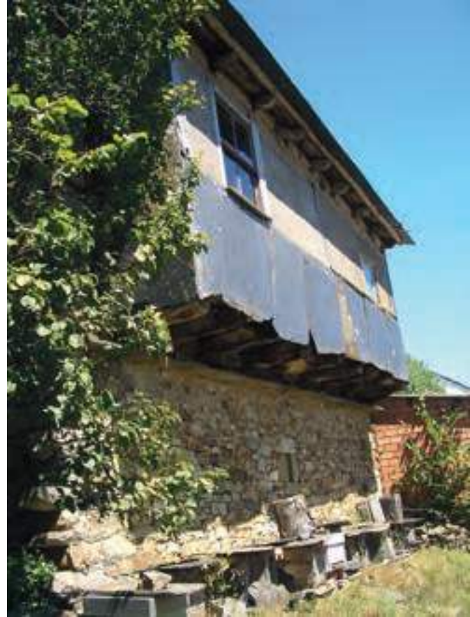
Balconada costal en una granera de dos pisos. Casa de Carbajal (Llandecarballo, Grandas).
