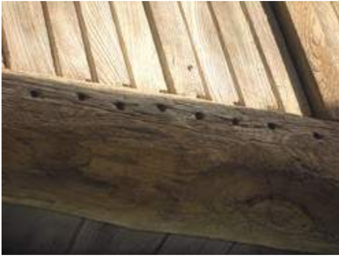
Detalle de los orificios de salida del agua en la viga de un cabazo. Se aprecia también el encaje de las duelas. Casa Xastre (Llenderozos, Vegadeo).
