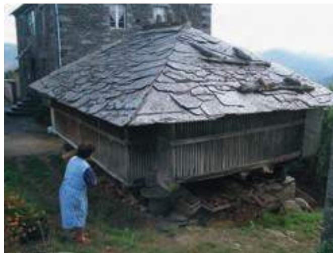
Panera con cabazos de secado externos y una balconada al valle. Casa Falcas (Villanueva, Boal).
