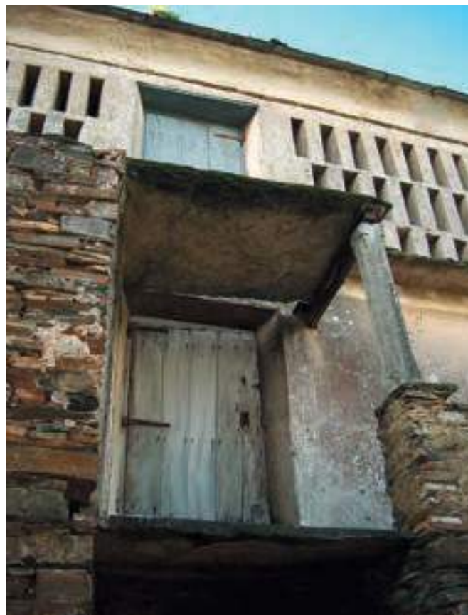
Escaleras de piedra y acceso sustentado con columna de piedra en el cabazo de casa Xerardo (San Julián, Ribadeo). En un penal, una placa recuerda su construcción en 1866 «a dispensa de D. Jesús Rodríguez Murias, por su esposa».
