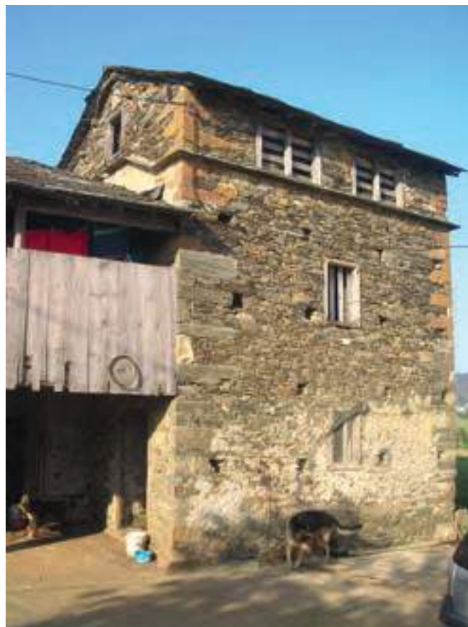
Ventanas de aireación, antes cerradas con persianillas de madera, para regular la entrada de aire. Casa Colasón (La Cruz, Valdés).
