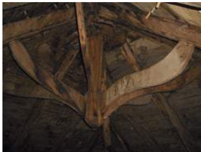
Enano magistralmente acodado en un hórreo de grandes dimensiones. Casa Vella de Vilarello (Allonca, A Fonsagrada).
