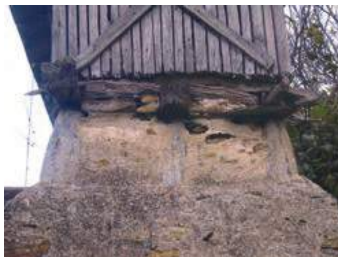
Detalle de los pies de piedra del cabazo de la página siguiente, que fueron emparedados con posterioridad.
