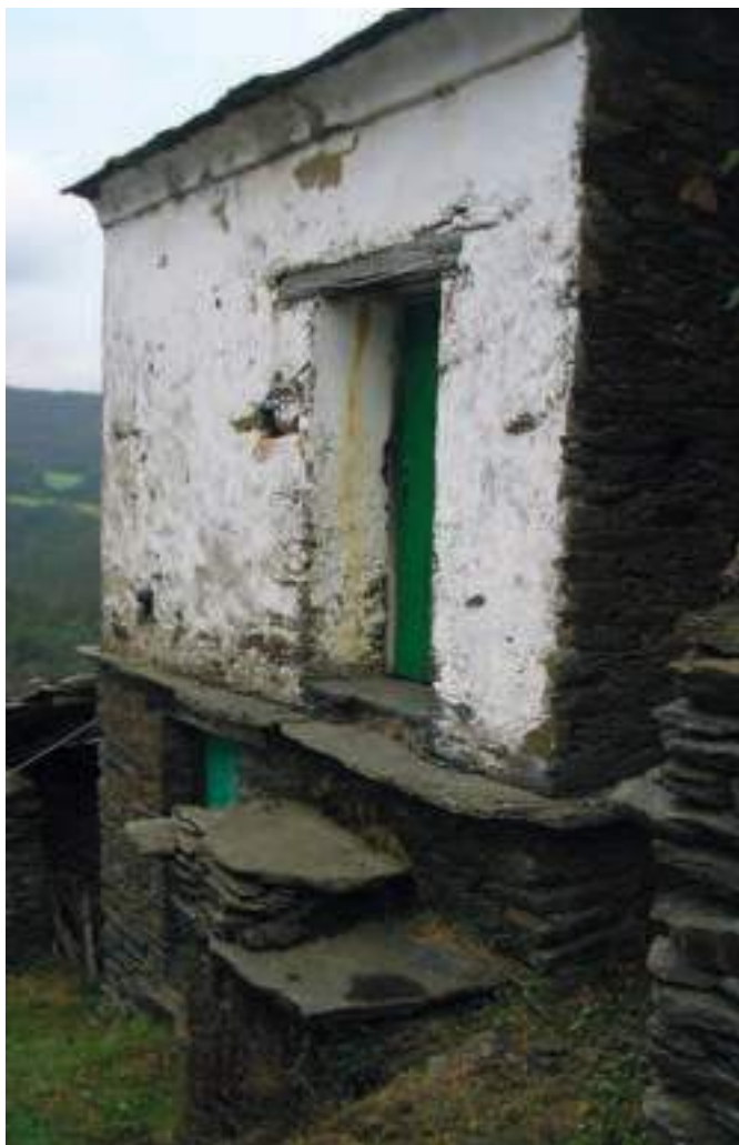
Pequeña granera de dos plantas, con acceso directo a la cámara mediante una escalera de piedra que aprovecha el desnivel del terreno. La cámara está subdividida en un nivel superior (desván) para las patatas y uno inferior en el que se secaba el maíz abriendo las ventanas. Casa Cerrao (Vivedro, Coaña).
