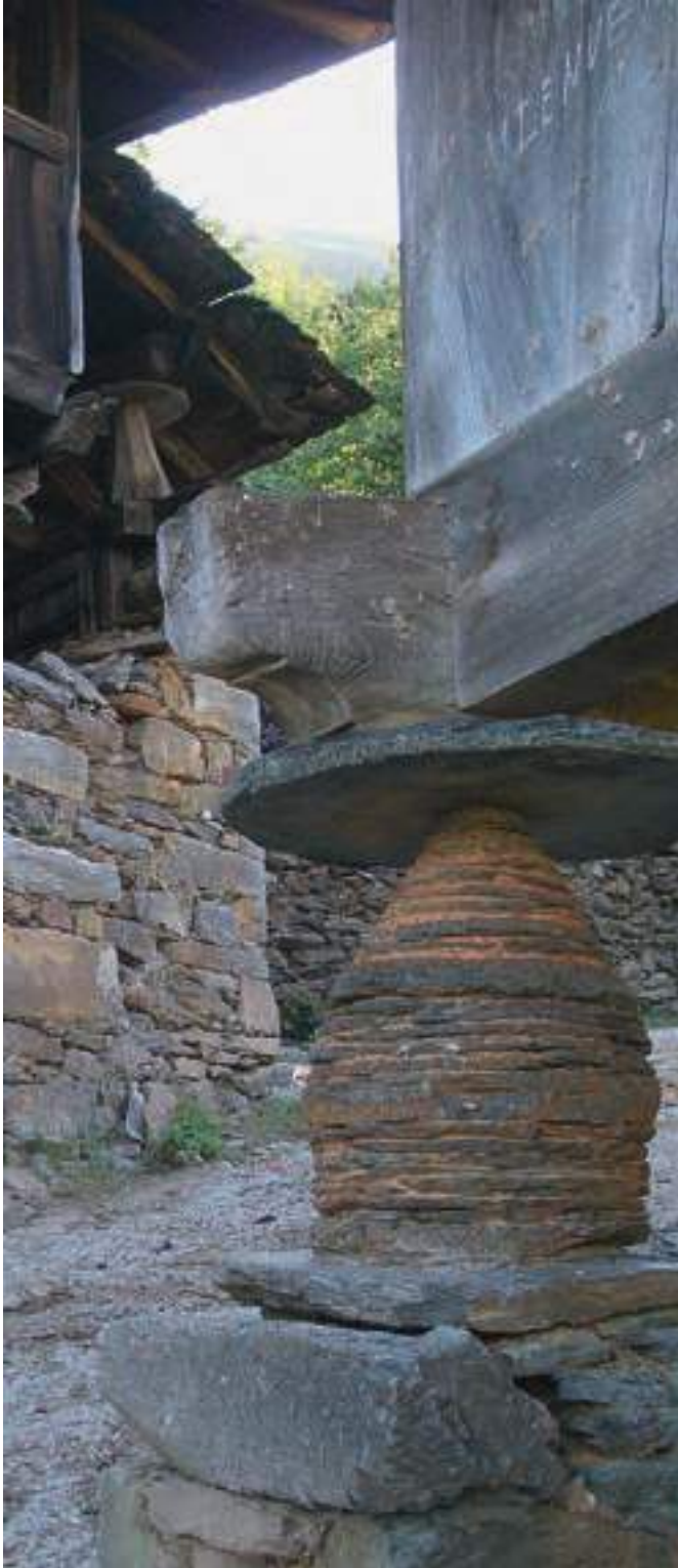
Pies de rodajas finas pizarrosas cuidadosamente emparedadas. La panera del fondo tiene un faldón apoyado sobre pies de madera. En primer término, Panera Casa Gómez y al fondo, panera Casa Canto (Villanueva, Allande).
