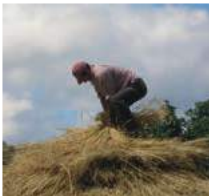
En la zona apical es necesario colocar un espesor superior de paja, y es la única parte del hórreo en la que los haces se doblan, para asegurar la estanqueidad de la cubierta.
